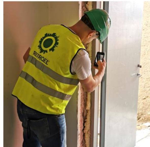
Ombrukskartlegging av bygning for å identifisere bygningskomponenter som er egnet for ombruk Foto: Resirqel AS
