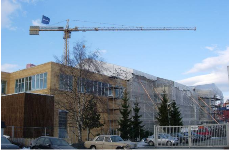
Figur 6.1 Skolebygg i Trondheim under oppføring under full værbeskyttelse. Med økt isolasjonstykkelse blir det viktigere å unngå at konstruksjonene fuktes opp under bygging, og bruk av teltsystemer eller planlagte lokale tildekninger er mulige tiltak. Foto: SINTEF Byggforsk.
