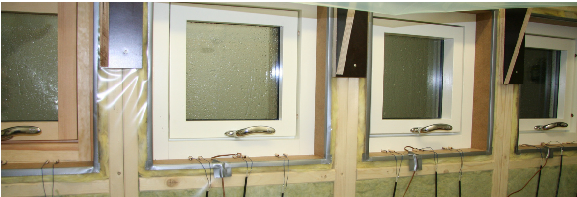
Figur 7.5 a Vinduene som ble brukt i fullskala fuktforsøkene sett fra innsiden (varm side)
