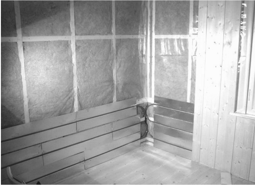
Fig. 3.5. Eksempel på veggvarmeanlegg der varmemfordelingsplatene er montert til lektene etter metode b i fig. 3.4.
