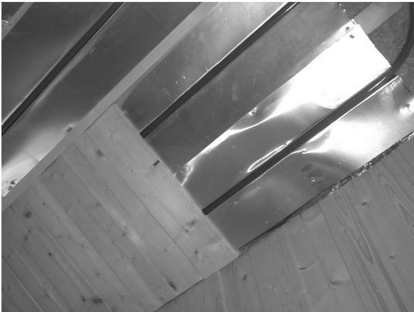
Fig. 3.6. Eksempel på takvarmeanlegg i en skråhimling der varmemfordelingsplatene er montert etter metode a i fig. 3.4.
