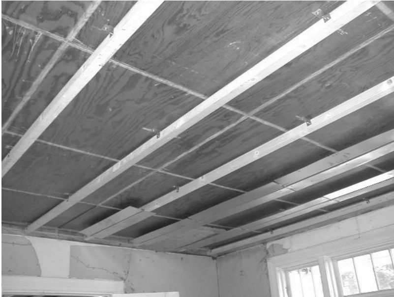
Fig. 3.6. Montering av sekundærlektene med lydbøyer i eksisterende himling.
