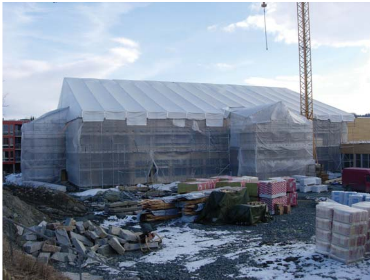
Figur 3.15 Nardo skole under oppførelse under full værbeskyttelse. Foto : SINTEF Byggforsk
