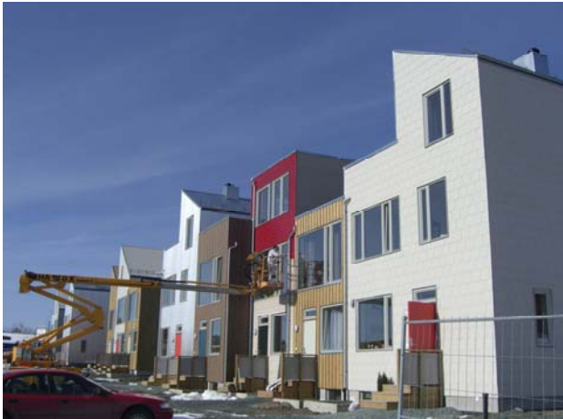
Fig. 1.5 Boliger bygd med massivtreelementer i taket. Foto: SINTEF Byggforsk
