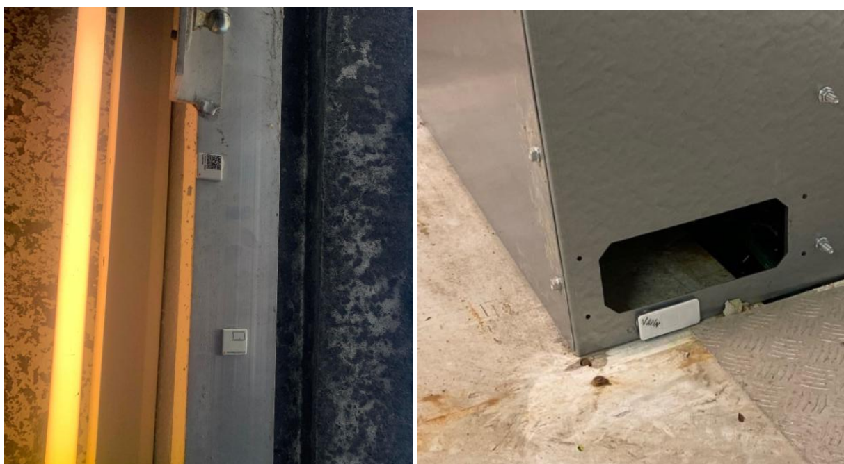
Figur 3 Dørsensorer til venstre (øverst: magnetisk sensor, nederst: proximity sensor). Vannsensor til høyre.
