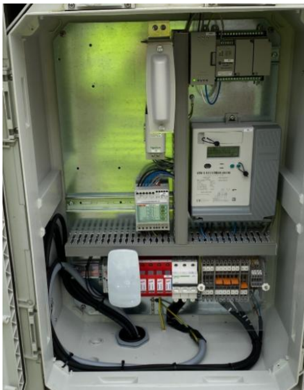
Figur 4 Gateway (hvit boks nede til venstre) i NSO-skap.
