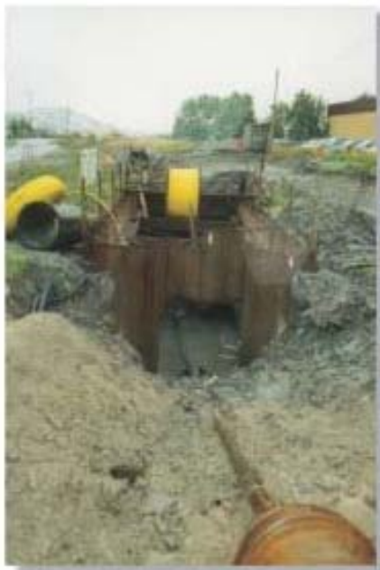
Dikeveien, Fredrikstad kommune Dim.: 800 mm - Lengde totalt 1050 m i 4 etapper
