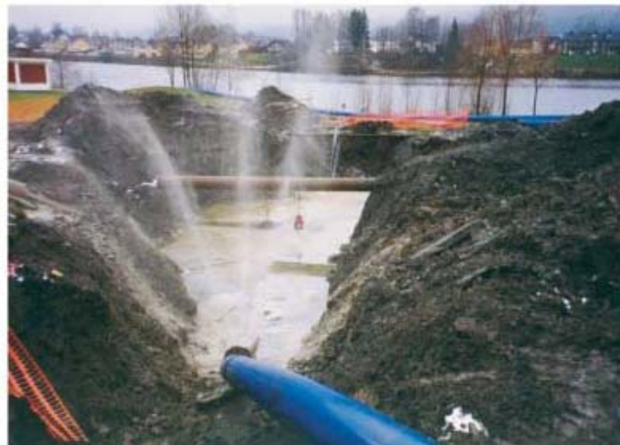
Elvekryssing, Drammen kommune Dim. 400 mm - lengde 450 m
