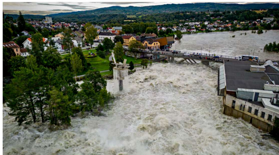
HØNEFOSS: - Når vannet har nådd toppen og trekker seg ned igjen, er det størst fare for ras, sier ordfører Kirsten Orebråten i Ringerike kommune til Dagbladet. Foto: N Foto: Ola Strømman / Dagbladet
