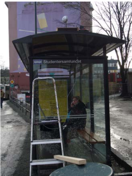
Figur 5-2 Bildet av busskuret (i retning sørover) med BT-enhet på taket.
